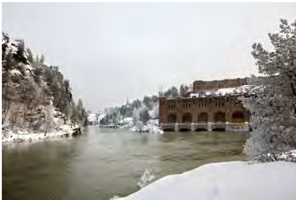
Kraftstationen vid Olidan. Bergsbranterna och vattnet utgör ett dramatiskt landskap där vattenkraften har kunnat utvinnas och utvinns fortfarande. Vid älven började stadens tillblivelse. Foto: Trollhättans stad
